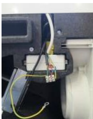
4.5 - Remonter avec précaution le module en laissant le bornier de connexion à l'extérieur. Dénuder les fils des 3 câbles du filtre coupés ultérieurement et les connecter au bornier de connexion en respectant la couleur des fils.
